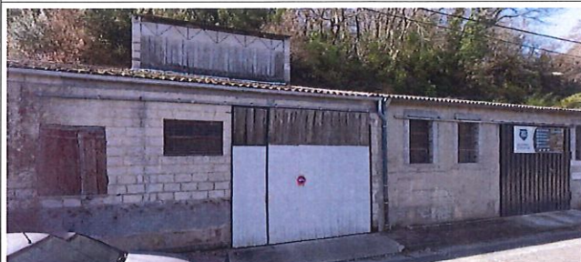
TC 3 – 47, rue des Roches
