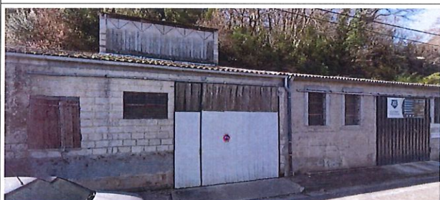
TC 3 – 47, rue des Roches
