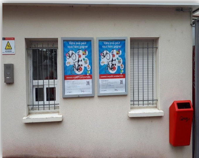
Mur local exploitation Parking du Bois d'Amour.
