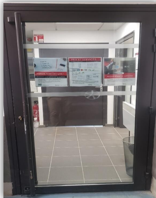
Porte vitrée bureau d'accueil Parking Centre-Ville.
