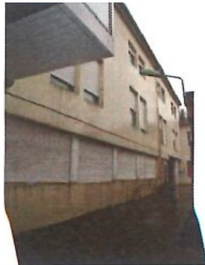
Bâtiment 13 – Scanner – Chirurgie- Oncologie
