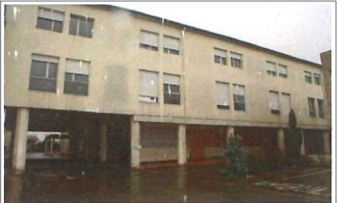
Bâtiment 12 – Radiologie - Scanner
