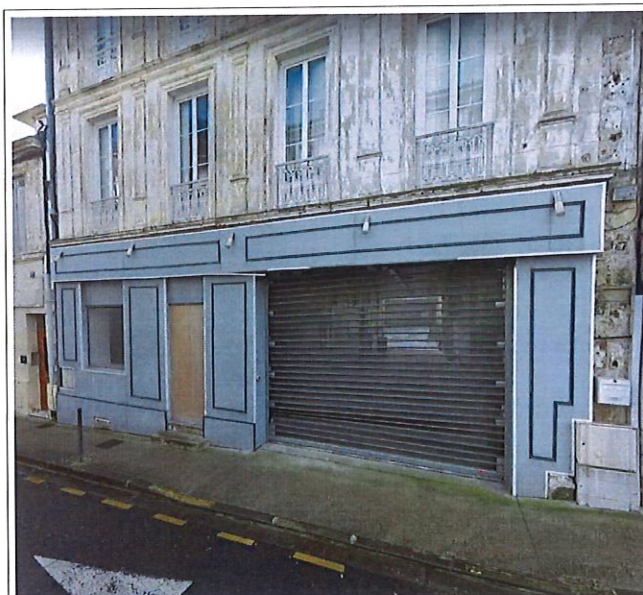
Façade Rue Eugène Pelletan
