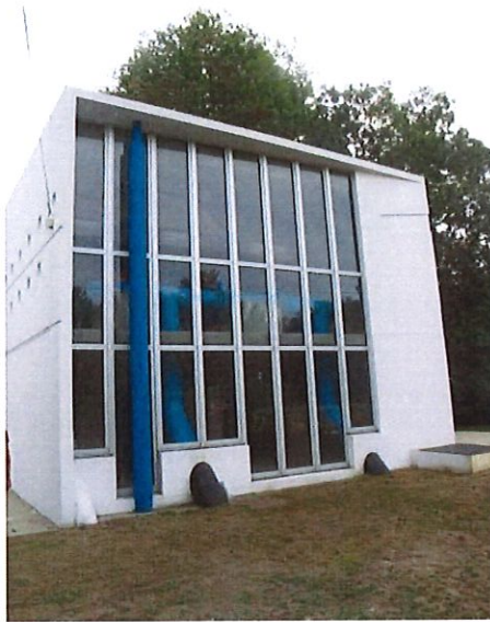
POMPAGE : La source de Lucérat (captage d'eau)
