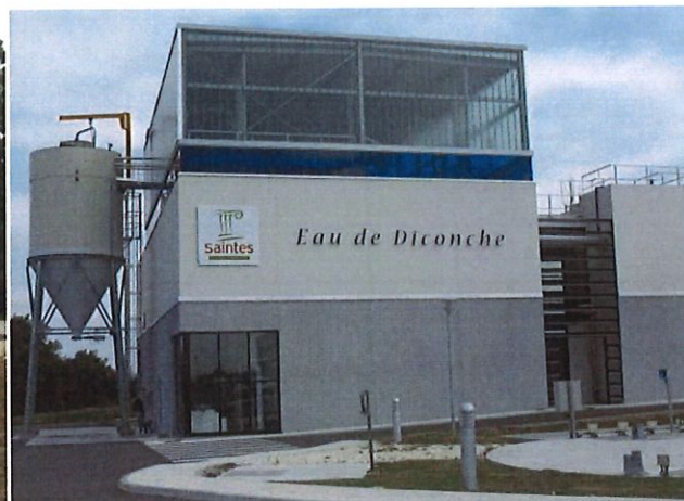
TRAITEMENT: L'usine de traitement/potabilisation de l'eau de Diconche
