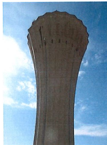
7 réservoirs dont le château d'eau des Boiffiers
