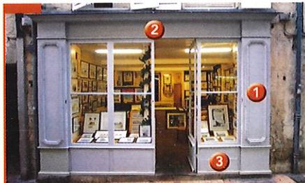
La devanture est apposée en applique sur la baie. Elle est composée de coffres latéraux (1) d'une corniche (2) et d'un soubassement (3). Elle convient bien aux façades en rez-de-chaussée dont tout élément architectural maçonné a disparu.
