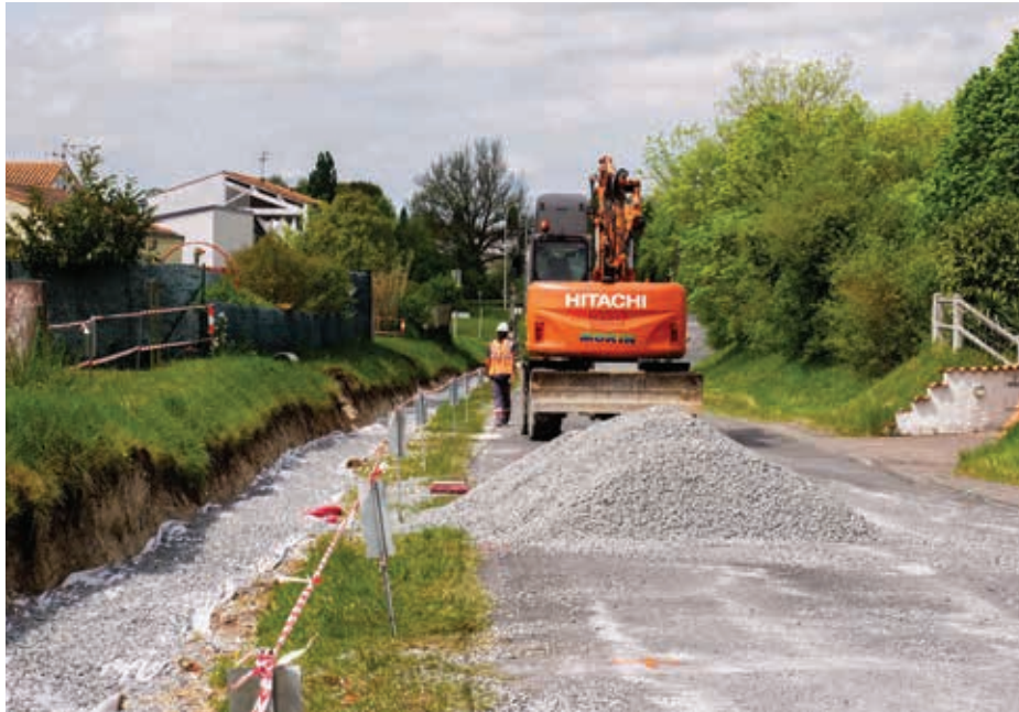
Ces rues du quartier de la Boisnarderie avaient besoin d'être refaites.
