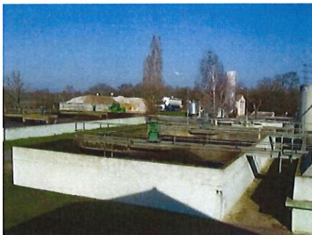
La station d'épuration de Lormont
