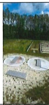
La station d'épuration du bois rulaud à filtre planté de roseaux
