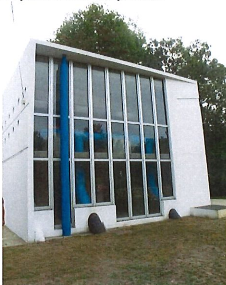
POMPAGE : La source de Lucérat (captage d'eau)
