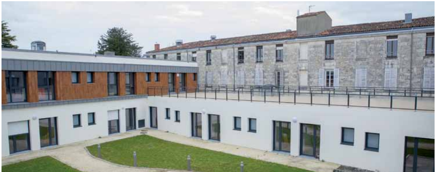
Les travaux ont permis l'ouverture de 27 chambres supplémentaires
