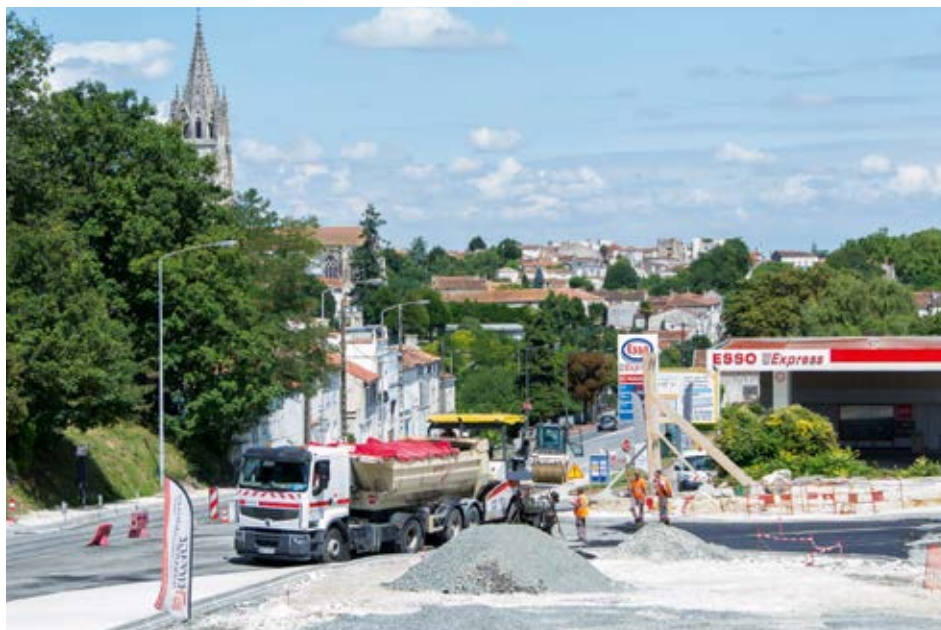
Vue des travaux l'été dernier
