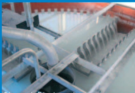
Réacteur de Décarbonatation
