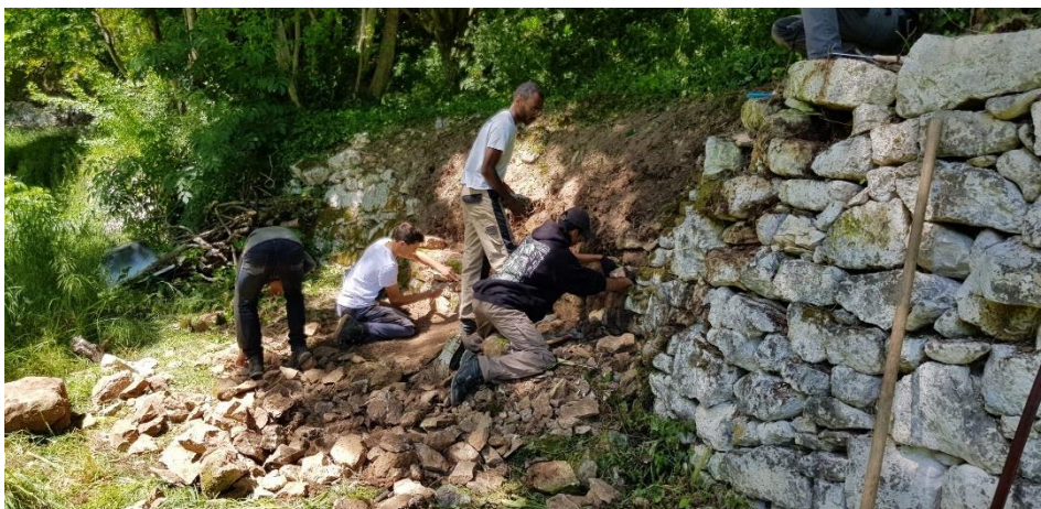
Photographie d'un exemple de chantier participatif sur remise en état d'un mur en pierre sèche, pouvant être réalisé sur la commune de Saintes.
